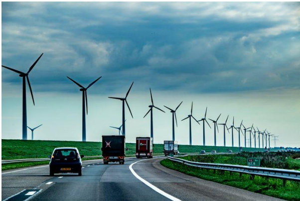
Windturbines langs autowegen ( foto Tubantia)
